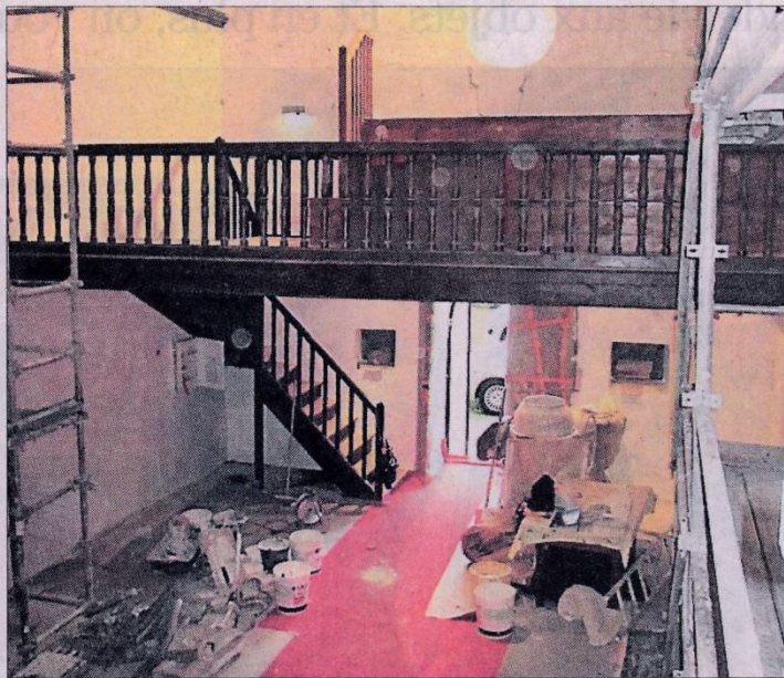
► L'intérieur de la chapelle en travaux.
