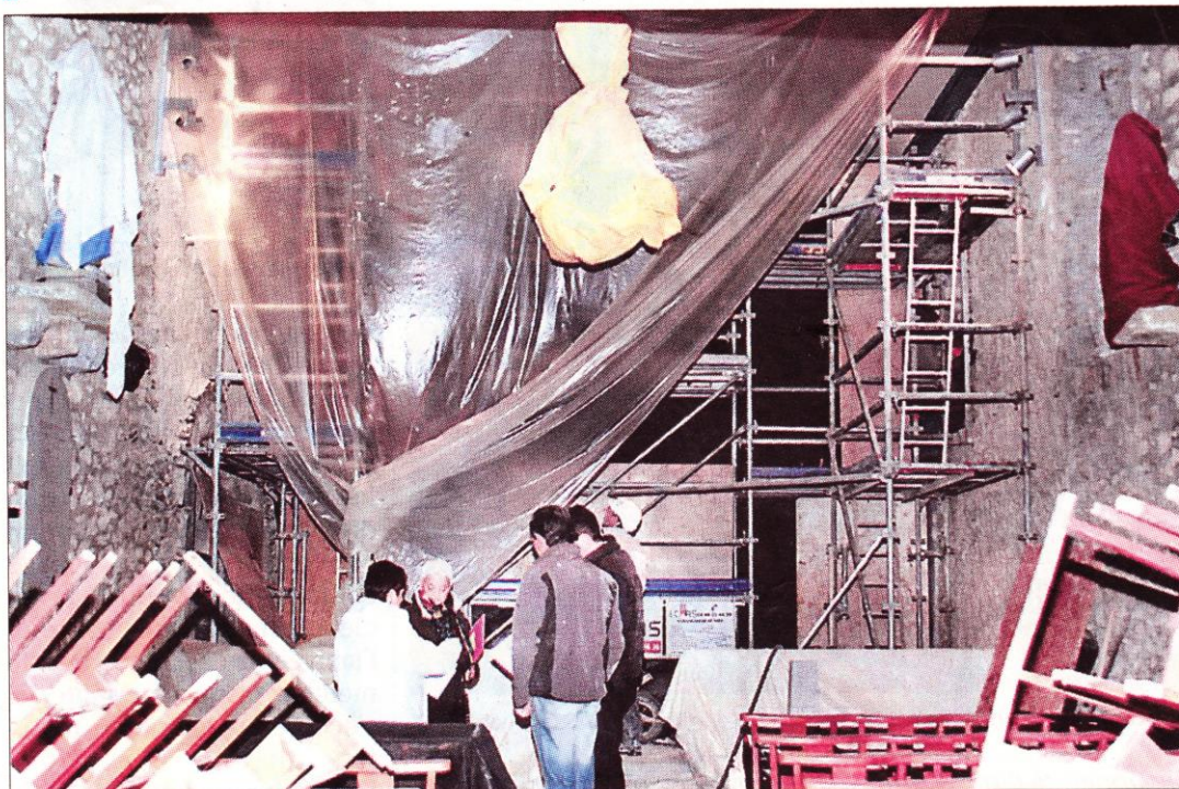
La chapelle est équipée d'un échafaudage.
